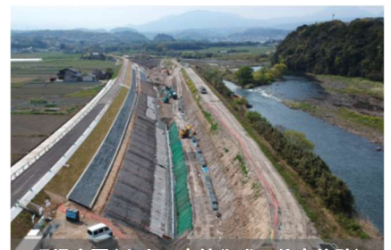
現場実習(土木工事技術職の仕事体験)
